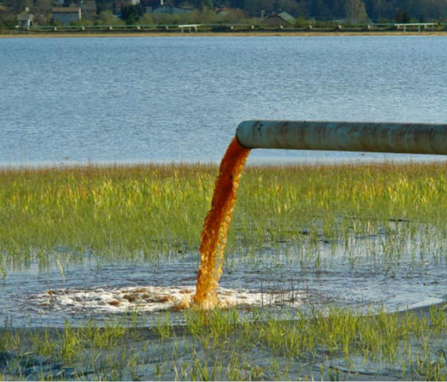
Figure 2 : Rejet des eaux usées dans les lacs.
